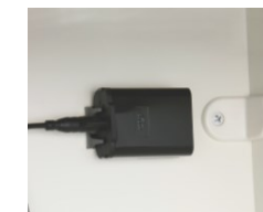
バッテリー式 自動水栓の電源は電池式です。電池の形式：CR-P2を使用しています。
